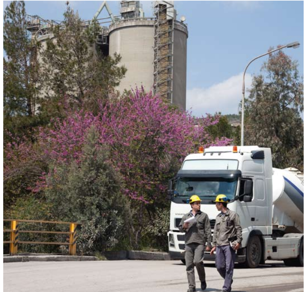
Εργοστάσιο Καμαρίου, Βοιωτία
